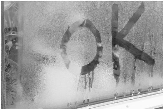
Das Aussenglas steht im direkten „Strahlungsaustausch“ mit dem Himmel. Je nach Einbausituation kann nun dieser Strahlungsaustausch (besonders in klaren Nächten) zu einer starken Abkühlung des Aussenglases führen.
