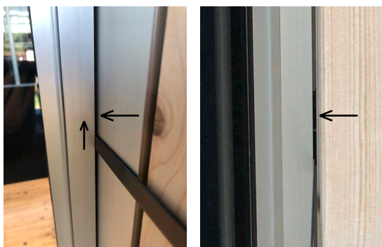
Åpning for nødopplåsing inntil anslagsprofilen
