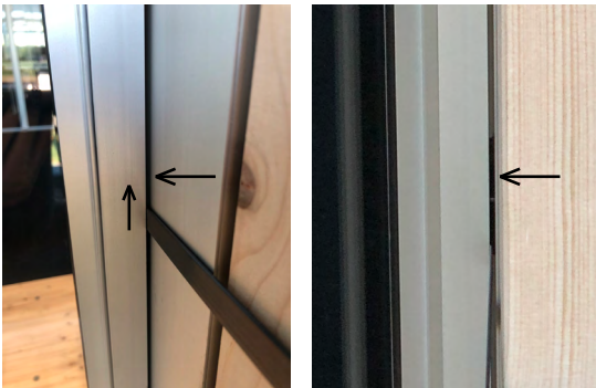
Notentriegelungs-Schlitz neben Anschlagprofil
