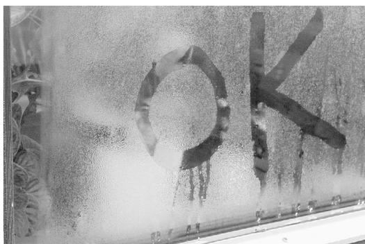
Il vetro esterno effettua uno “scambio di irradiazione” diretto con il cielo. Secondo la situazione di montaggio questo scambio di irradiazione può causare (specialmente in notti chiare) un forte raffreddamento del vetro esterno.
