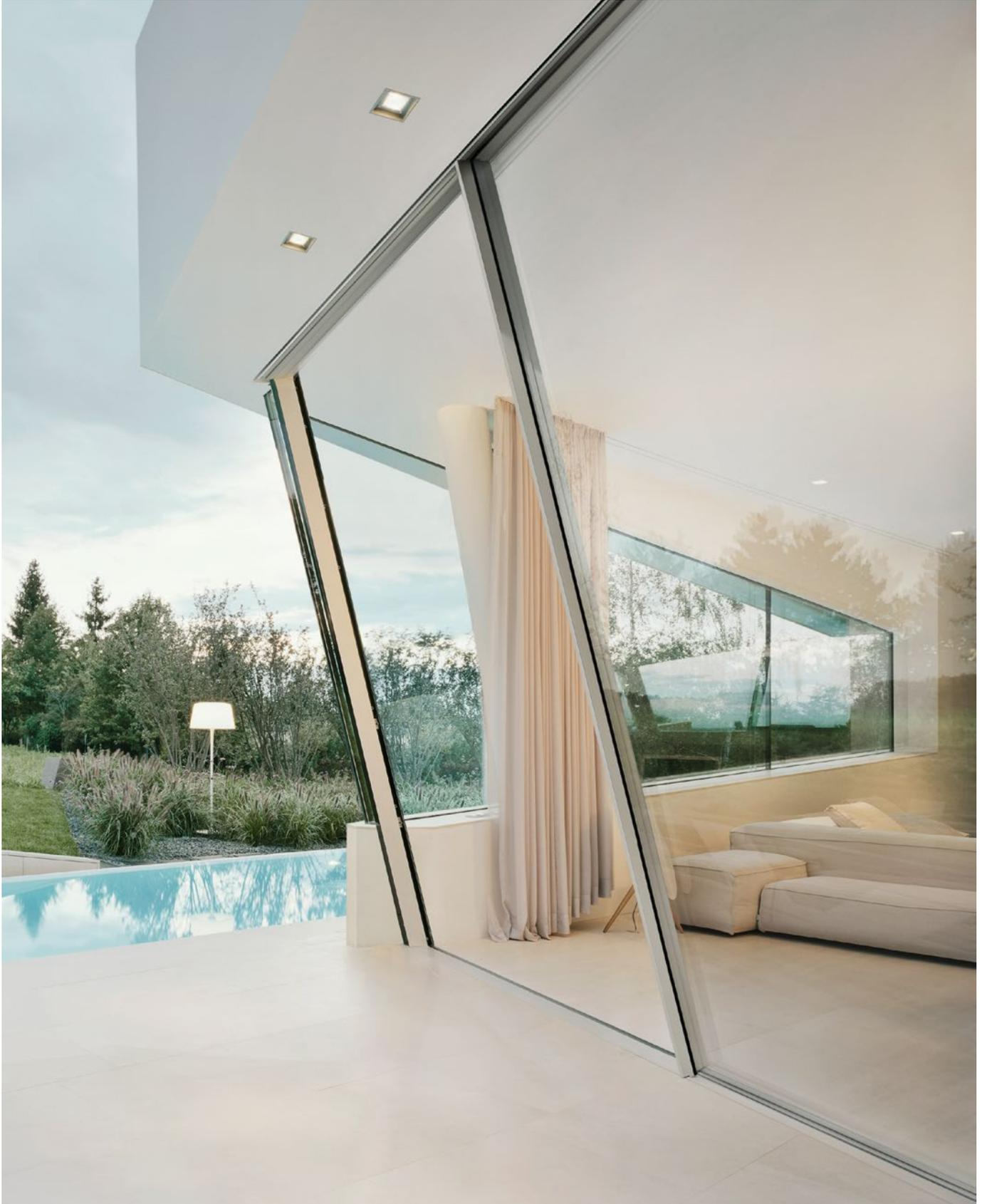
Die Schiebefenster neigen sich bei Slope bis zu 20° aus der Vertikalen wahlweise in den Wohnraum hinein oder aus der Fassade heraus. Das System erfüllt alle Standards von Sky-Frame und ermöglicht eine besondere Raumgeometrie. Die spezielle Lagerung gleicht sämtliche vertikalen und horizontalen Kräfte aus und sorgt so für leichte Laufeigenschaften. Die Systementwässerung funktioniert auch entgegen der Neigung und erfüllt alle Ansprüche an die Schlagregendichtheit.
