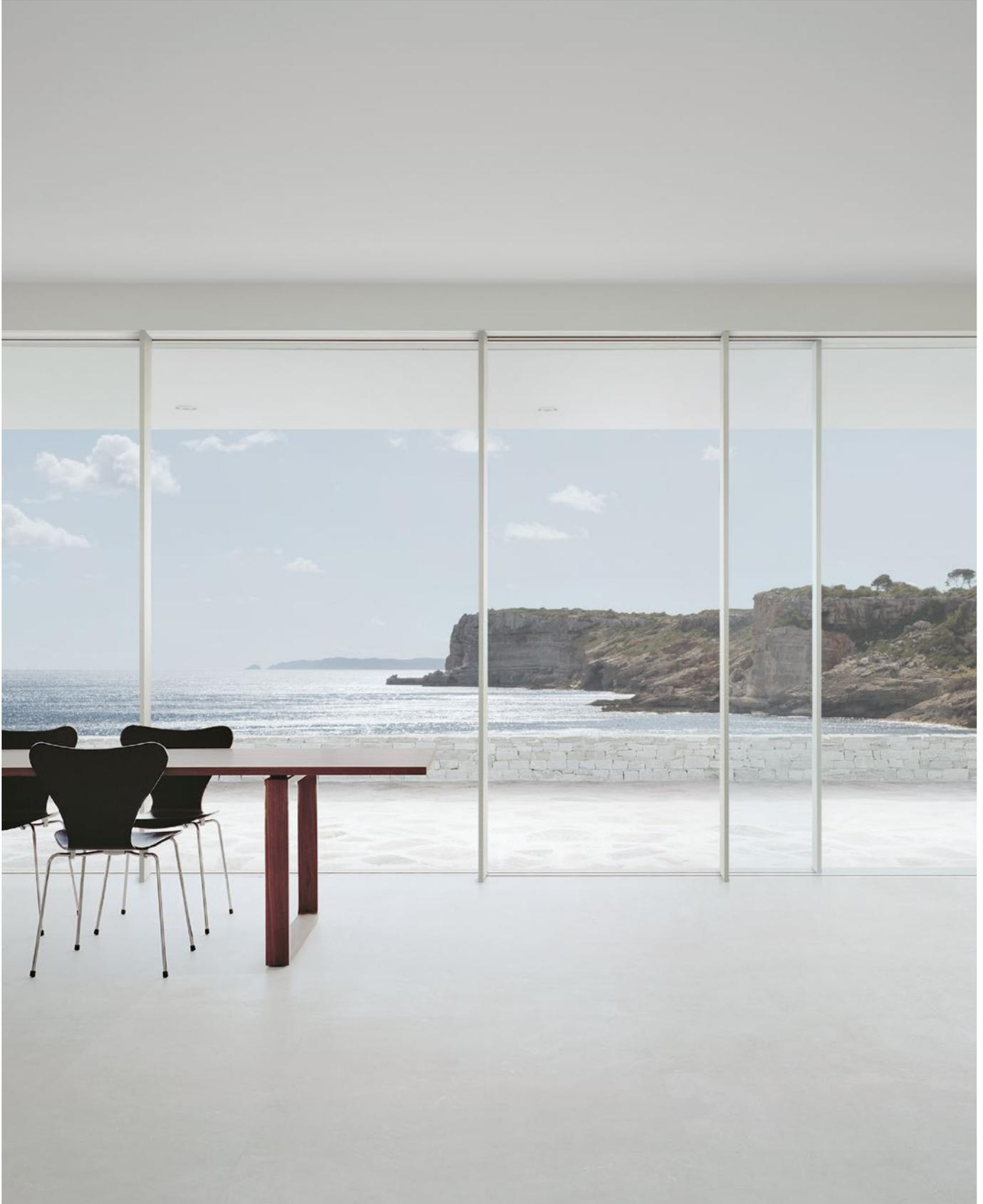
El sistema Sky-Frame se completa con la fina varilla vertical, que muestra un ancho de apenas 30 mm. Disponible en tres profundidades (66/90/110 mm) y para requisitos de estática elevados se puede reforzar con hasta cuatro insertos de acero. De este modo, los acristalamientos fijos sin marco pueden combinarse en grandes superficies con ventanas corredizas y forman una membrana de vidrio enrasada y continua.
