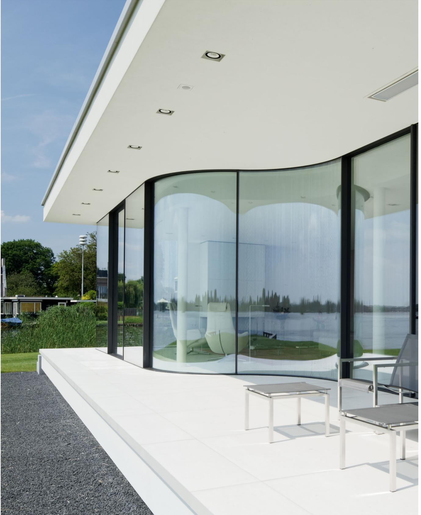
Gli elementi di Sky-Frame Arc disegnano naturalmente le curve creando linee armoniose nello spazio abitativo. Le vetrate curve si muovono con facilità e, su richiesta, possono essere equipaggiate con un motore elettrico. Il sistema, oltre a soddisfare tutti i requisiti di Sky-Frame, rappresenta un elemento organico che lascia ulteriore spazio alla creatività.
