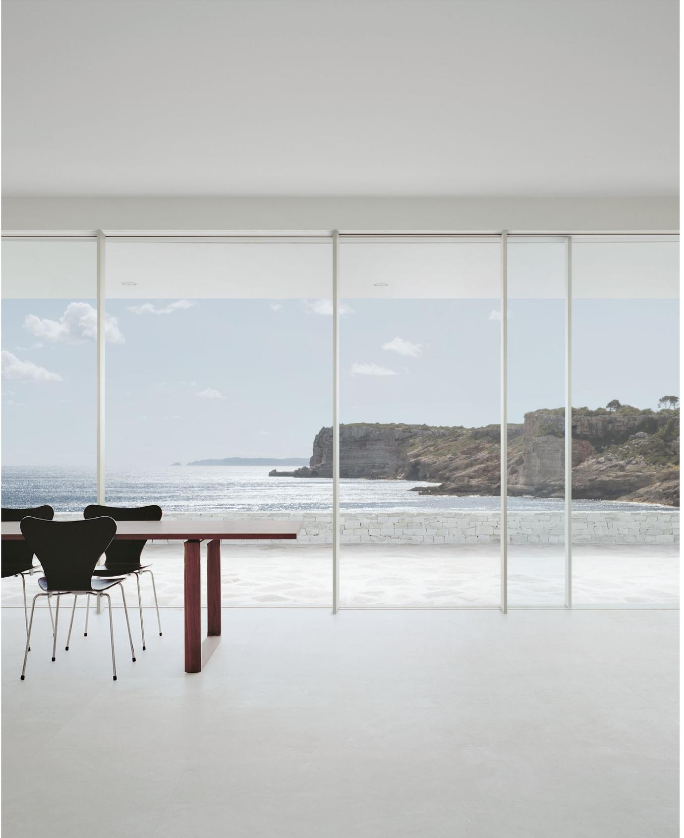
Il sistema Sky-Frame viene integrato dal montante in filigrana, con larghezza visibile di soli 30 mm. Disponibile in tre spessori (66/90/110 mm). Per soddisfare requisiti statici superiori è possibile rinforzarlo con fino a quattro inserti in acciaio. Le superfici vetrate fisse senza telaio possono essere così combinate su grandi superfici con finestre scorrevoli, formando una parete di vetro complanare continua.
