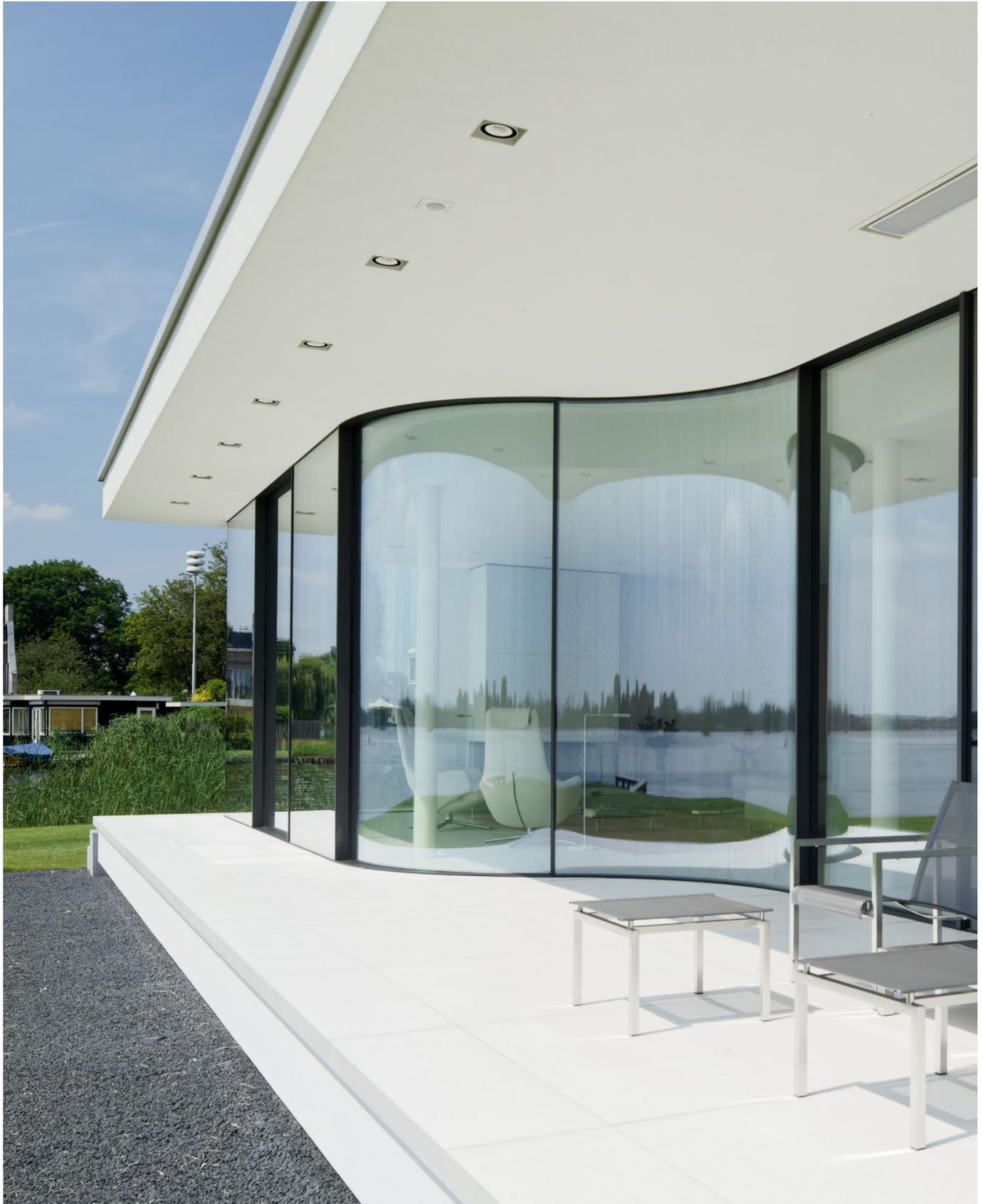
Радиусные конструкции повторяют изгибы помещения и придают ему органичную форму. Для перемещения створок не требуется значительных усилий, а по желанию возможно оснащение электроприводом. Система Arc отвечает всем требованиям Sky-Frame и, являясь элементом современной архитектуры, предоставляет дополнительную свободу в организации жилого пространства.
