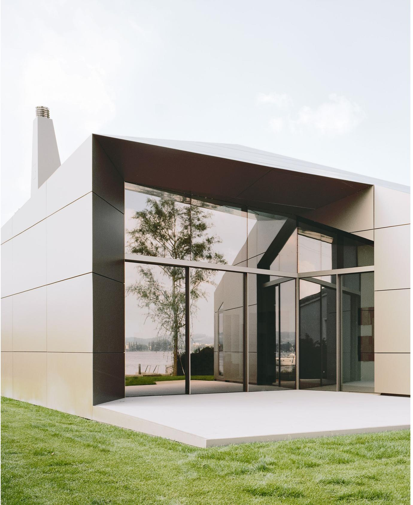
Даже в стандартном исполнении Sky-Frame обеспечивает великолепную защиту от взлома благодаря усилению стеклопакета с помощью GFK-профилей и многоточечному замку. В зависимости от требуемого уровня безопасности раздвижные окна могут быть оборудованы дополнительными компонентами.
